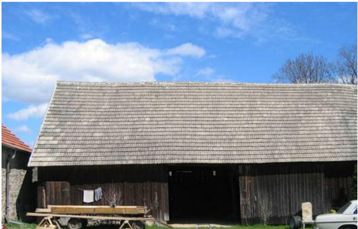
Abbildung 1: Ansichtsfoto Dachfläche Blickrichtung NO
