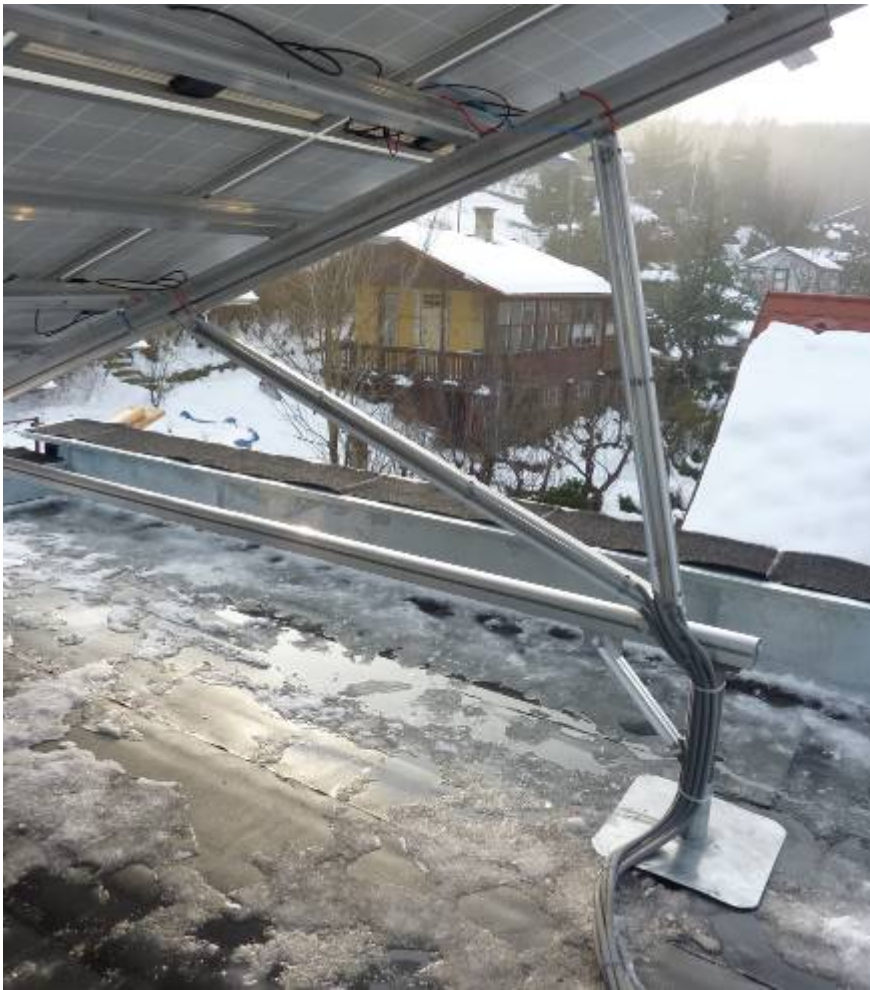
Abbildung 12: Dachansicht PV-Modul Montagesystem
