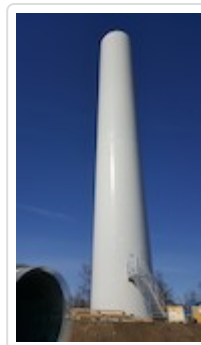
2021 Windpark Gross Schweinbarth Turm Errichtung2_(c)Profes
