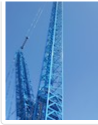
2021 Windpark Gross Schweinbarth Kran Errichtung_(c)Profes
