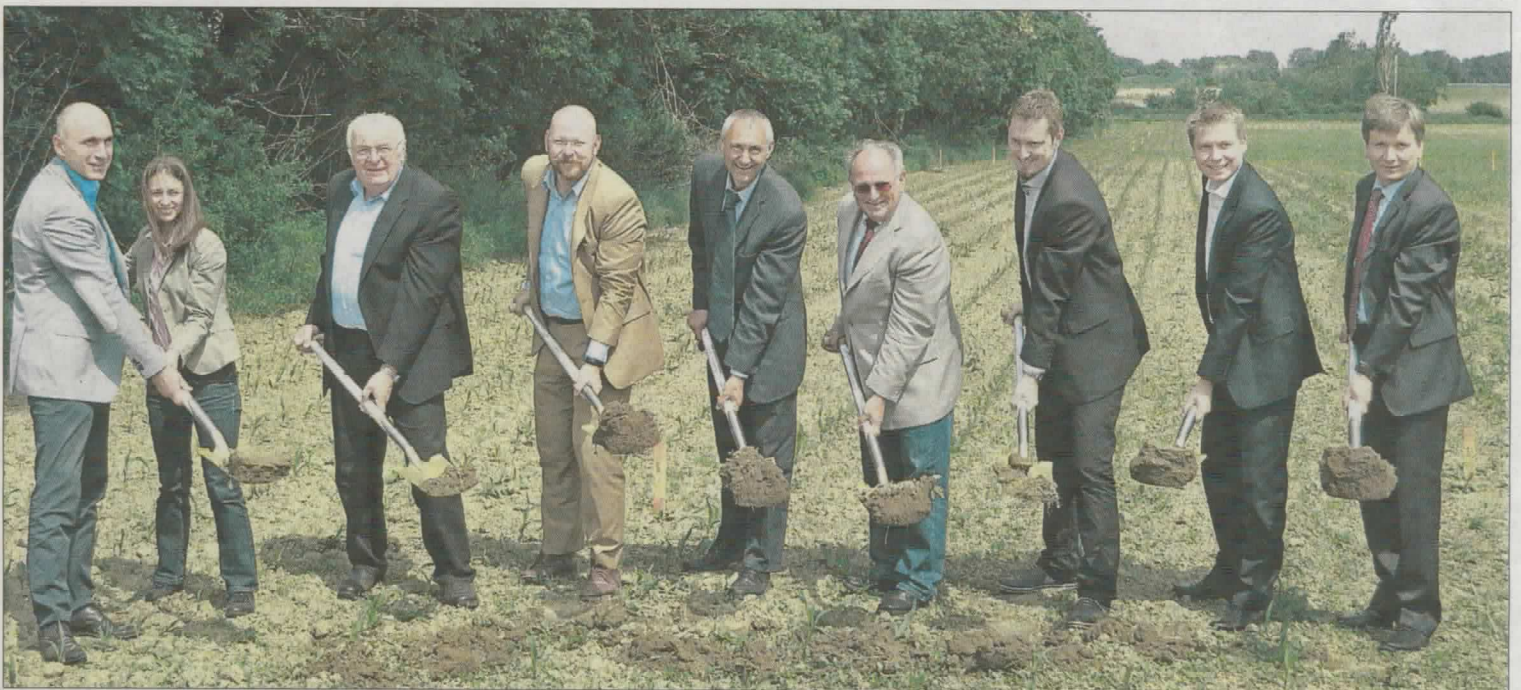
Auftakt zu den Bauarbeiten (im Bild v. l.): Martin Rosza und Daniela Dolkowski (Vestas), Vize-Bürgermeister Rudolf Trakall, Karl Fatrdla (Vestas), Martin Krill (PROFES, Projektleitung) Bürgermeister Hubert Zwickelstorfer, Christian Pirker (Leyrer&Graf, Baufirma), Karl Wittmann und Johann Breit (Erste Bank, Finanzierung).
