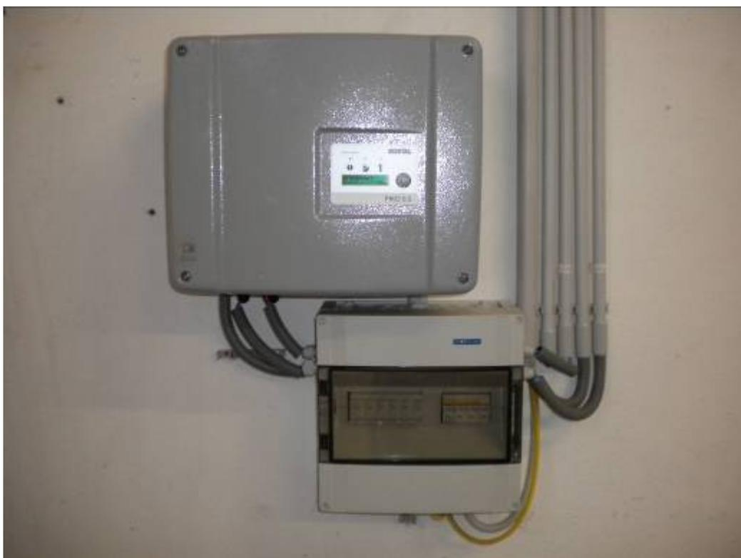
Abbildung 15: Kostal Wechselrichter mit Schutzeinrichtungen
