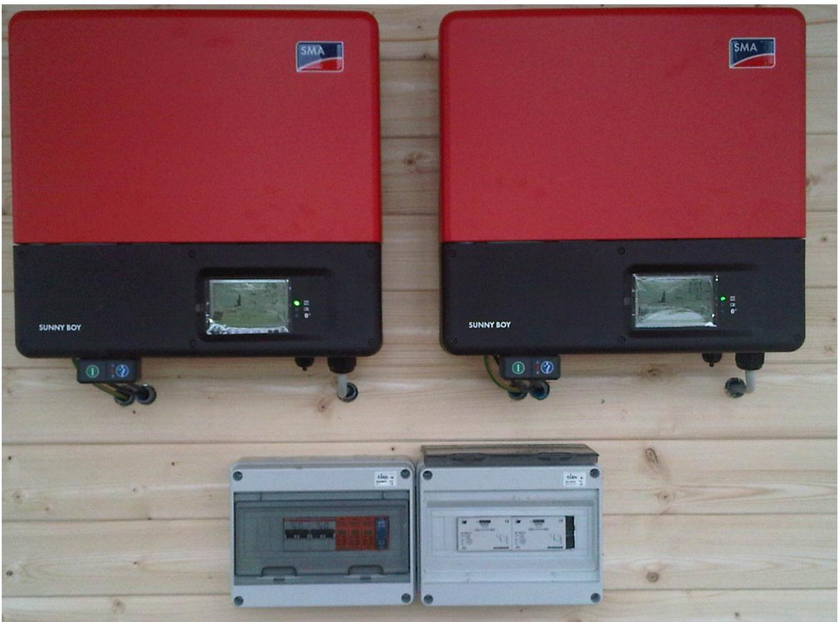
Abbildung 14: SMA Wechselrichter und Sicherungseinrichtungen
